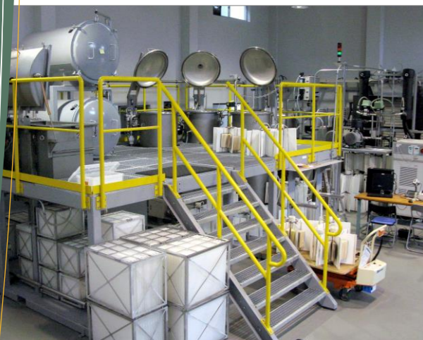
ブックキーパー脱酸性化処理プラント(さいたま市)
