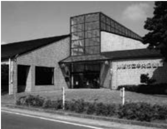
神栖市立中央図書館外観 所在地：茨城県神栖市大野原4-8-1 延べ床面積：2,600m 2 神栖市の人口：95,000人 神栖市の面積：147km 2
